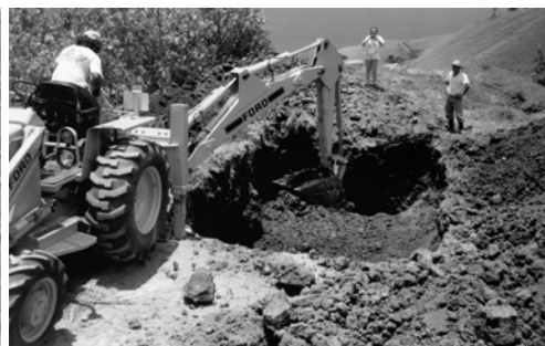
▲ 怪手在山頂上挖小池
