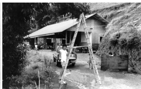
▲ 吉吉弟兄裝設電器設備
