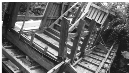
▲ 一九八四年守望高樓被國民黨鋸斷，屋頂翻覆在地上
