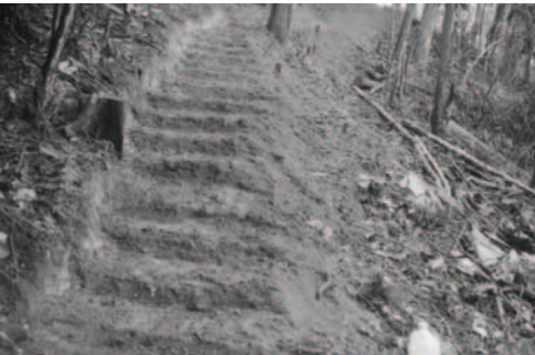
▲ 弟兄姊妹在這條路上修築梯道
