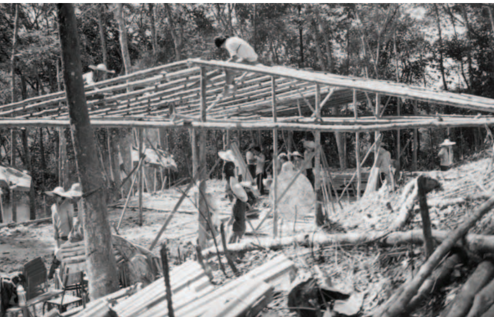
▲ 架設屋頂的樑木
