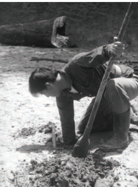
▲ 森騰弟兄為會所大柱子挖洞奠基
